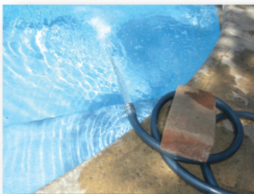
Ανεβαζομε νερο στη πισινά ως που να καλιπσει το πουρι ασβεστού.
